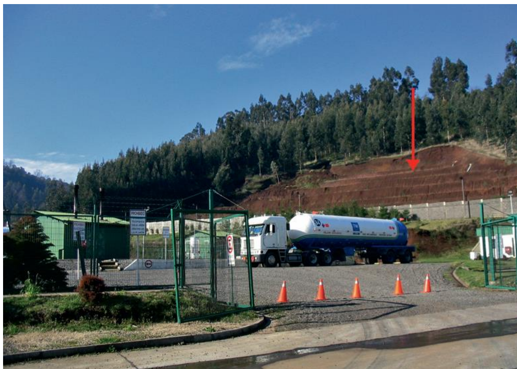
Figura N° 14. Ubicación (indicada por flecha roja) de deslizamientos rotacionales de suelo, ocurridos durante días de lluvias intensas el año 2003, en una ladera del cerro Ñielol junto a una planta de gas en el sector norte de la ciudad de Temuco. En la fotografía se observa el resultado de los trabajos de mitigación, con la estabilización del talud mediante modificación geométrica y la construcción de bancos.
