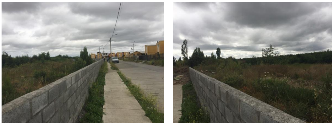
Figura N° 50. Fotografías de “obra de mitigación” para la mitigación de inundaciones en Labranza.
