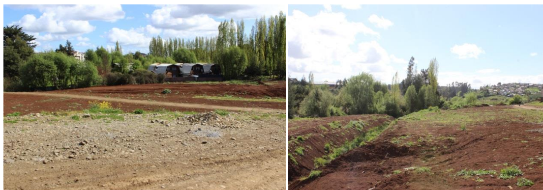
Fotografía N° 34. Fotografías de relleno de extensión en punto de descarga de la llanura aluvial del estero Coihueco.
