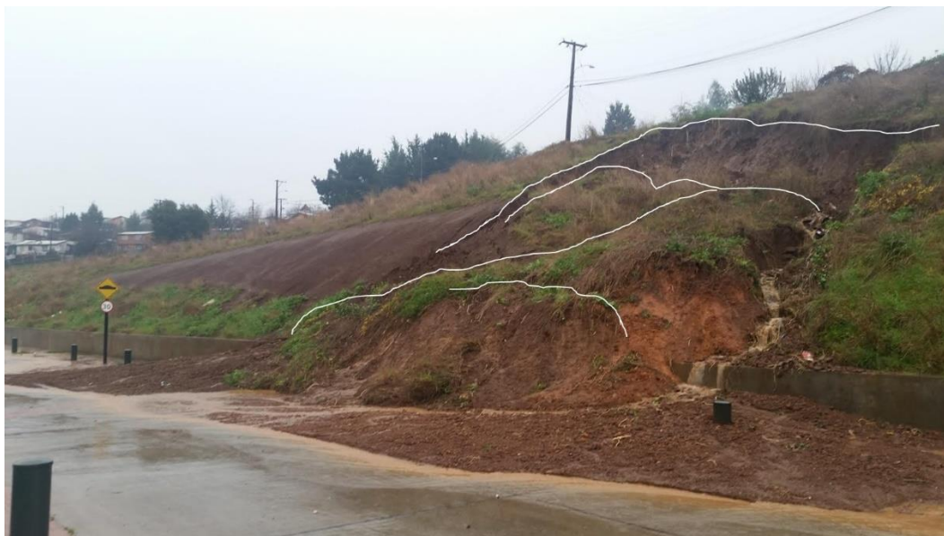
Fotografía N° 02. Deslizamiento ocurrido con fecha 16 de junio de 2017, en blanco, se muestran los cortes del deslizamiento – Sector Pedro de Valdivia.
