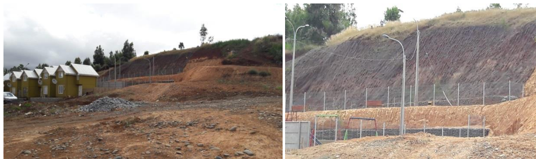
Figura N° 41. Fotografías de la habilitación del loteo Chivilcan a través de movimiento de tierras en quebradas de composición arcillosa.
