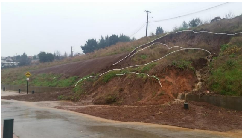
Figura N°73. Deslizamiento ocurrido con fecha 16 de junio de 2017. En blanco, se muestran los cortes del deslizamiento – Sector Pedro de Valdivia. Fuente: Elaborada Equipo Consultor, 2017.
