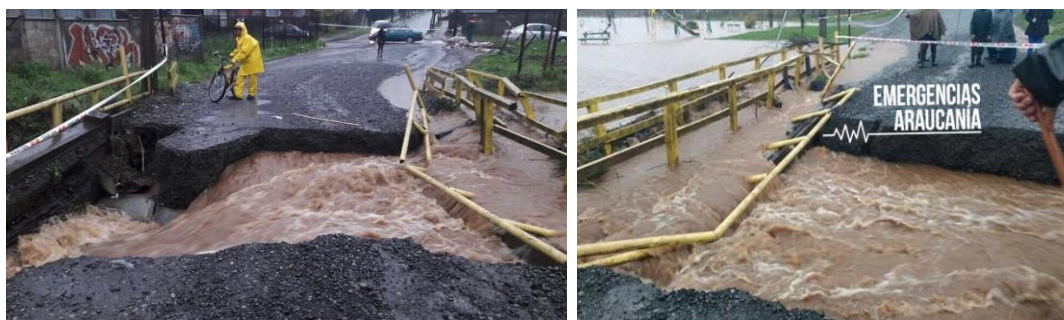
Fotografías N° 25 y 26. Desborde y tasa de erosión de estero Coihueco cortan puente de conexión entre El Carmen y Pedro de Valdivia (junio 2016).
